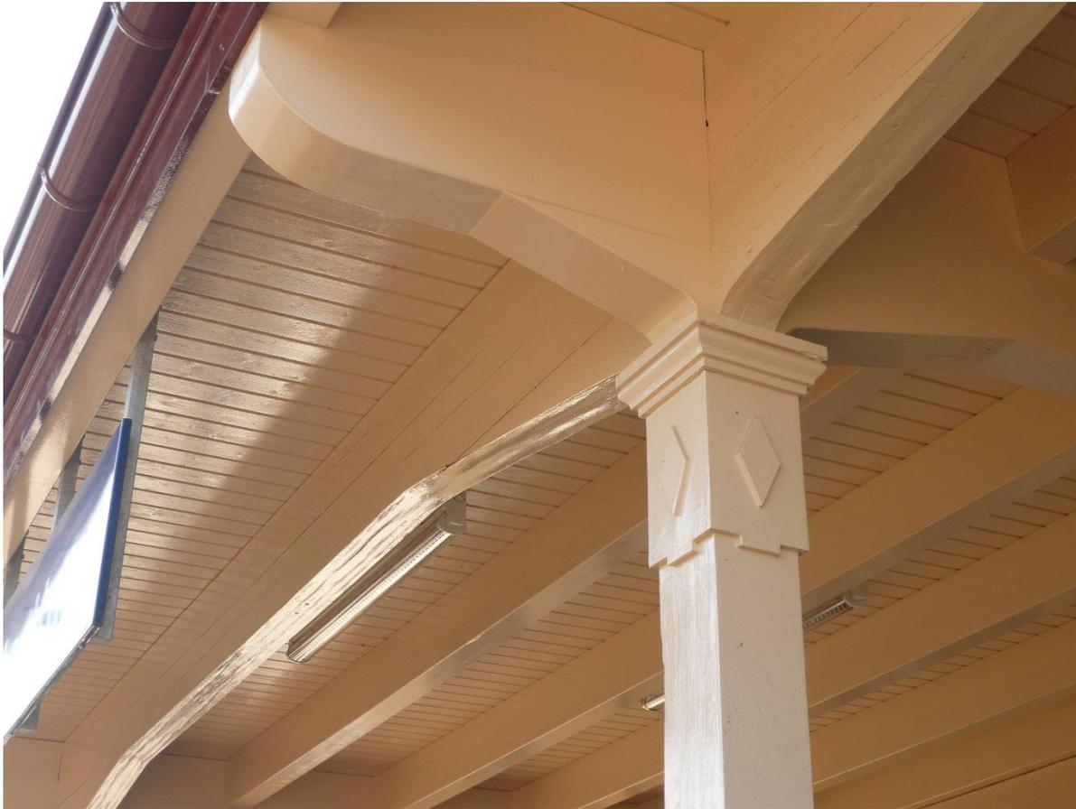
Das restaurierte Perrondach des Bahnhofs Oberwinterthur. Vorne zu sehen der erhaltene Binder der Originalkonstruktion. Im Hintergrund neue Trägerbalken.
