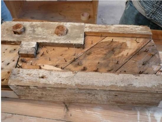
Teilstück ohne Decklamellen, Nagelung der unteren Schicht sichtbar.
