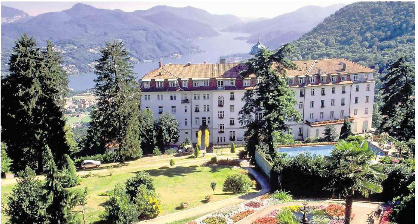
Wie eine kleine Festung thront das altehrwürdige Kurhaus Cademario inmitten einer prächtigen Parkanlage über dem Lago di Lugano. Bilder: zvg
