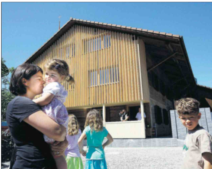
Das Sigristenpfrundhaus musste für die Sanierung praktisch ausgehöhlt werden.
