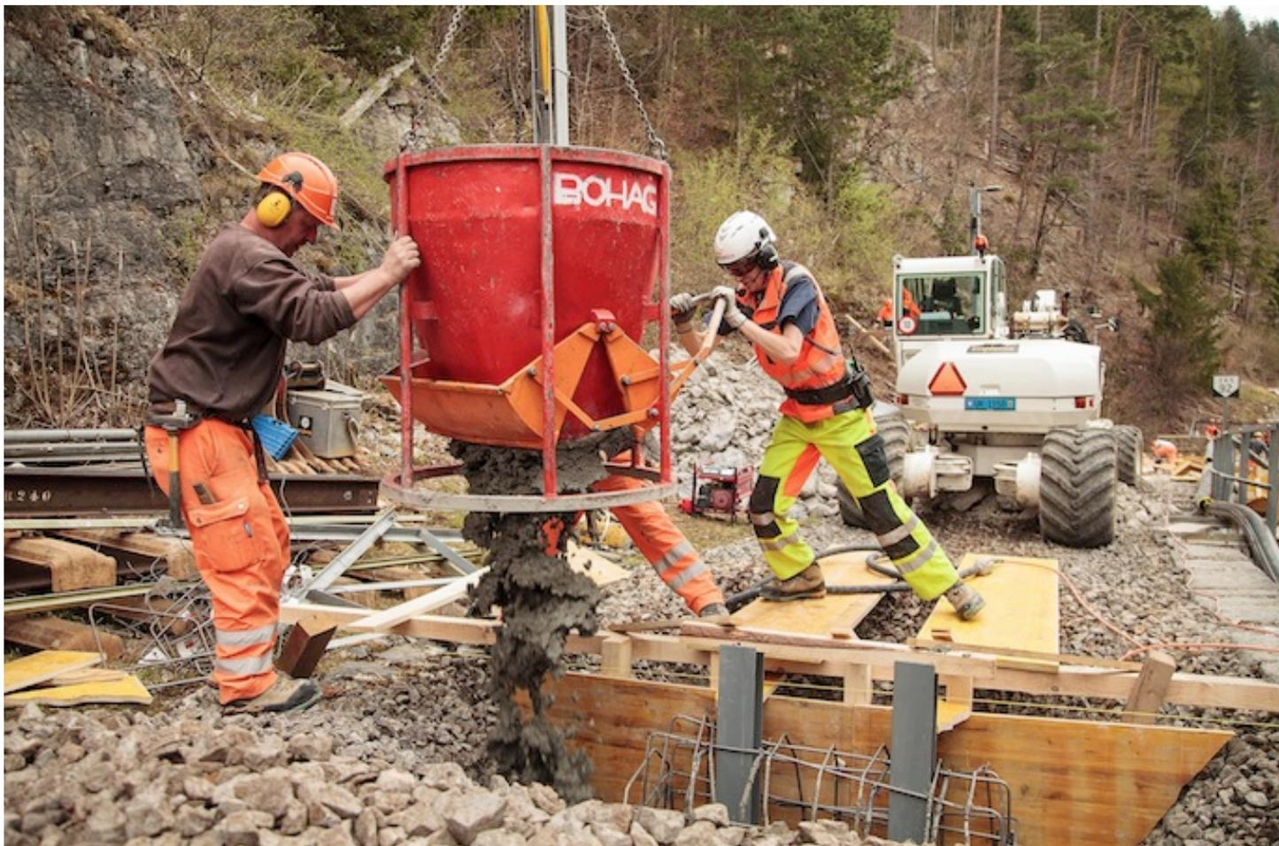
Den nötigen Beton muss ein Helikopter aus dem Talboden hochfliegen. Die Genauigkeit, mit welcher er den Behälter über dem Loch schweben lässt, ist beeindruckend.
